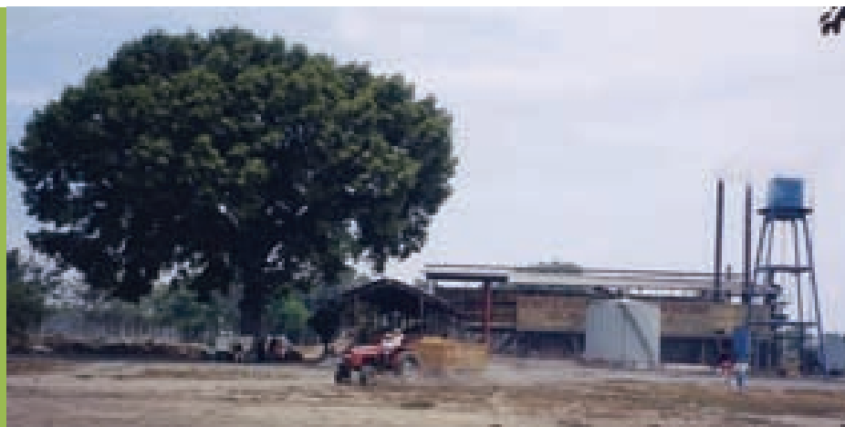
■ Vista de la planta extractora Bepasa en Acapetahua, Chiapas.
